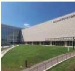
エスフォルタアリーナ八王子 [八王子市総合体育館] (約2,650m)
