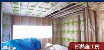
断熱施工例
