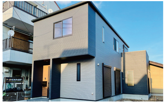
現地写真(1号棟)※2024年4月撮影
