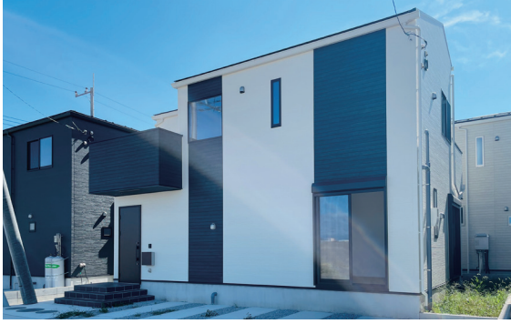
現地写真(8号棟)※2023年10月撮影
