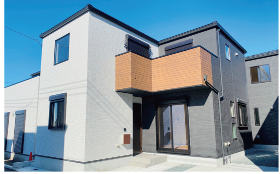
現地写真(12号棟)※2024年1月撮影
