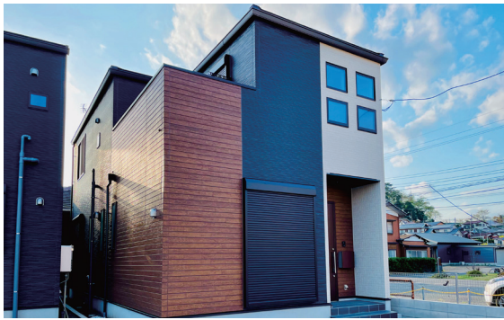
現地写真(5号棟)※2024年4月撮影
