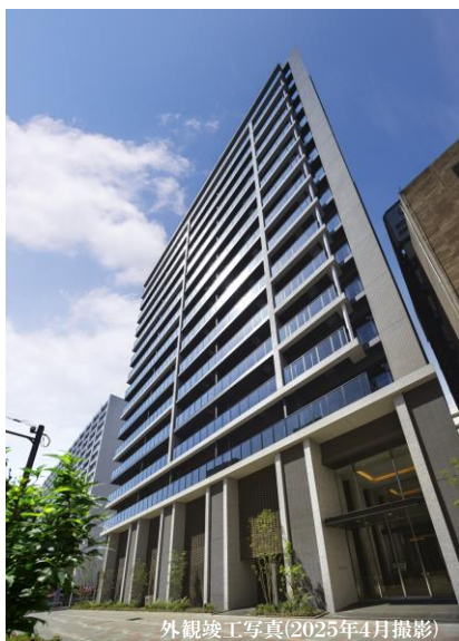
外観竣工写真(2025年4月撮影)
